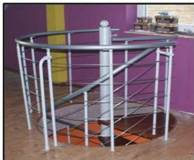
Balustrada ochronna schody przylegające do antresoli
