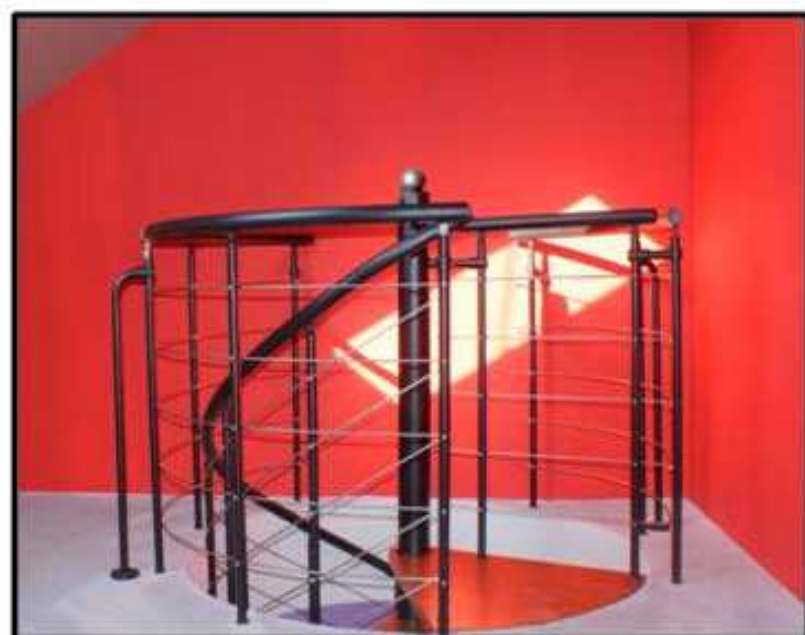
Balustrada ochronna schody przylegające do antresoli
